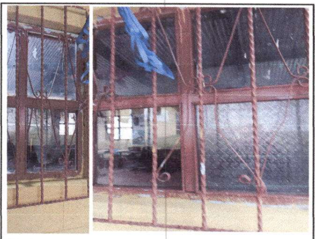
Foto 6: Sustitución de ventanas de madera por ventanas de metal, más vidrio
