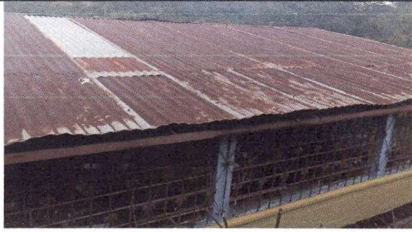
Foto1: Sustitución de lámina troquelada calibre 26 por lámina acanalada
