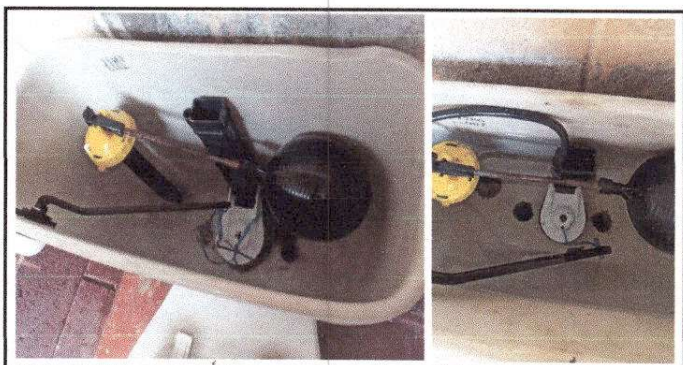
Foto 12: Sustitución de accesorios para tanques de sanitarios lavables
