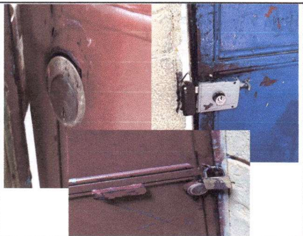
Foto 5: Sustitución de chapas que están descompuestas
