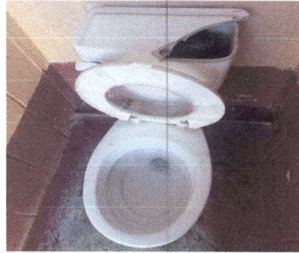
Foto14: Sustitución de un sanitario lavable
