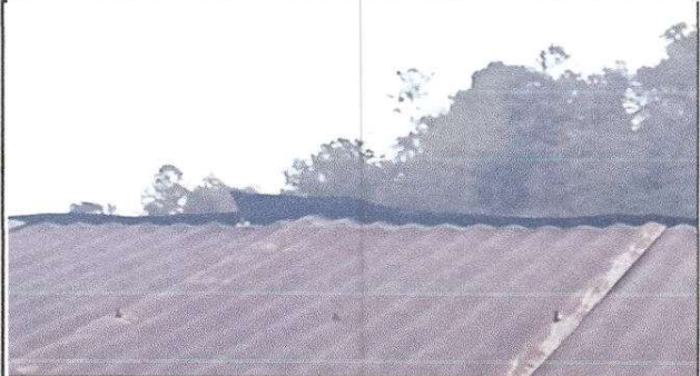
Foto 2: Sustitución de capotes por capotes de lámina aluzinc
