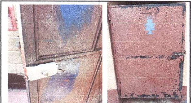
Foto 4: Mantenimiento de puertas de metal
