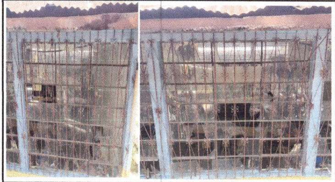
Foto 8: Mantenimiento de balcones (lijar, cepillar, pintar, reparar)
