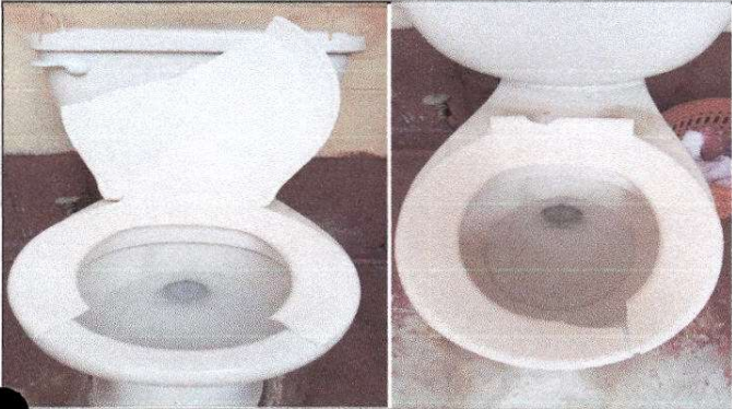
Foto 13: Sustitución de 5 tapaderas para sanitarios lavables
