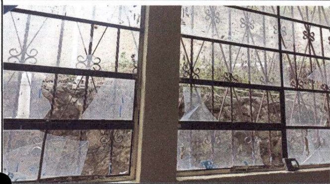
Foto 7: Sustitución de Vidrios en ventanales de metal por deterioro
