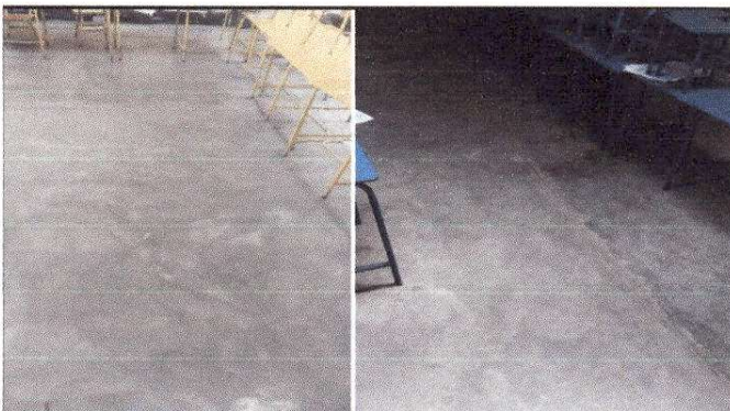
Foto 9: Sustitución de piso cerámico
