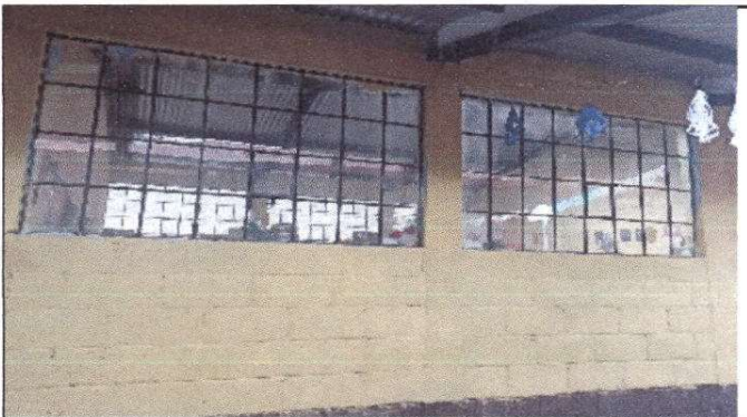
Foto15: Fabricación e instalación de balcones para protección del aula
